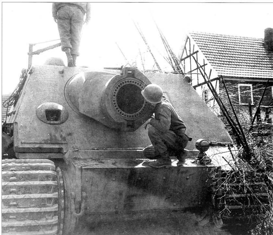
This Sturmmörser fell into US hands in the Nordrhein-Westfalen town of Drolshagen. Note the additional armor plating on the front slope of the vehicle. • Dieser Sturmpanzer fiel den US-Streitkräften im nordrhein-westfälischen Drolshagen fast unbeschädigt in die Hände. Man beachte die zusätzliche Panzerplatte am Fahrzeugbug. Das Fahrzeug ist anscheinend nur in sandgelb gestrichen. Auch der sonst übliche Zimmerit-Anstrich an der Wanne fehlt
