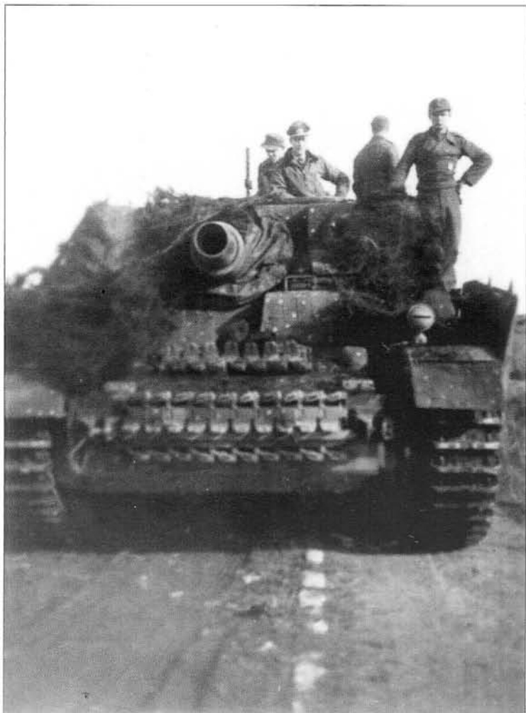
Several assault tanks of the 1st Company were lost as the result of faulty ammunition. This destroyed assault tank only had steel roadwheels on its front set of bogies. • Mehrere Sturmpanzer der 1.Kompanie gegen durch fehlerhafte Munition verloren. Bei diesem zerstörten Panzer waren nur der vordere Laufrollenwagen mit Stahllaufrollen ausgerüstet.
