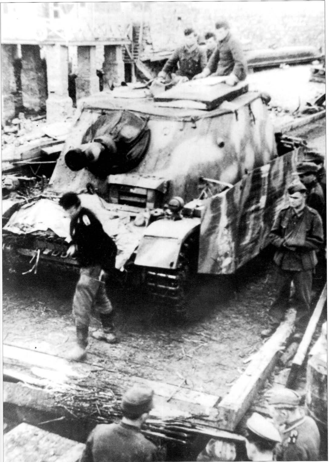
A provisional rain guard has been affixed above the Fahrersehklappe 80 of this assault tank. • Über der Fahrersehklappe 80 dieses Sturmpanzers ist ein provisorischer Regenschutz befestigt.
