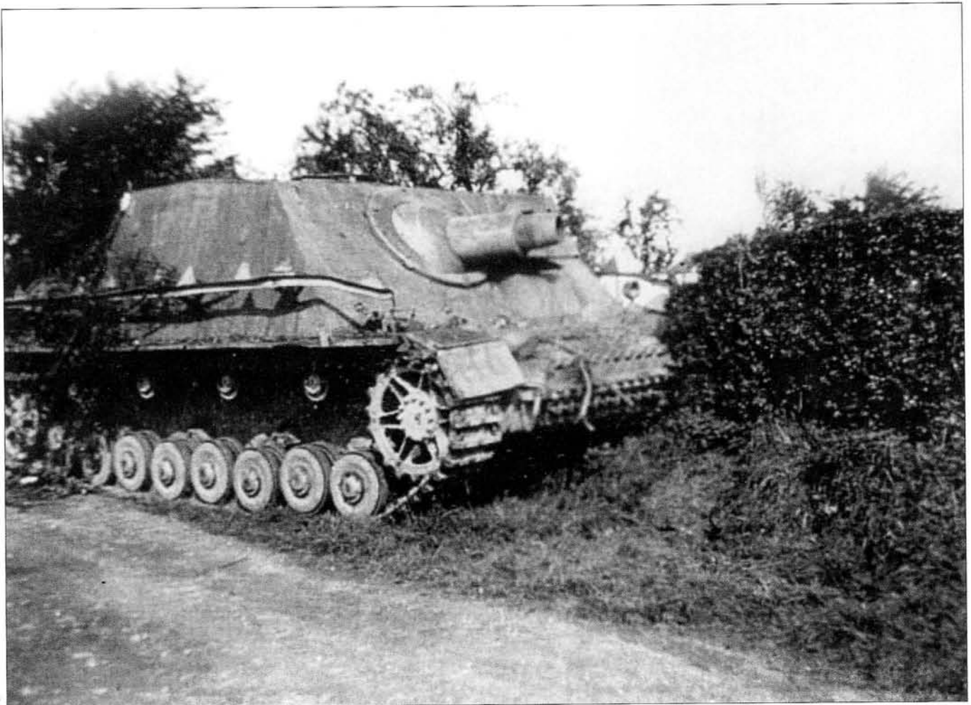
Another one was lost to enemy fire not too far from the village of Heggen. Note that the assault tank has been completely outfitted with steel roadwheels. • Ein weiterer fiel unweit der Ortschaft Heggen durch Feindbeschuss aus. Man beachte, dass der Panzer komplett mit Stahllaufrollen ausgerüstet ist.
