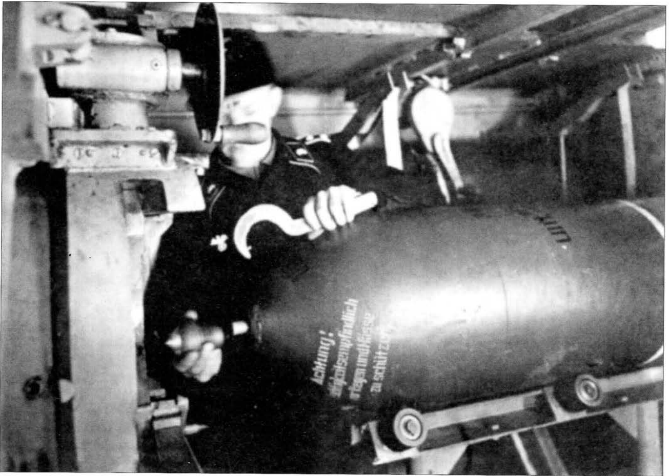
A member of the crew attaches an igniter to the round on the loading tray. • Ein Besatzungsmitglied bringt an einem auf der Ladeschale befindlichen Geschoss den Zünder an.
